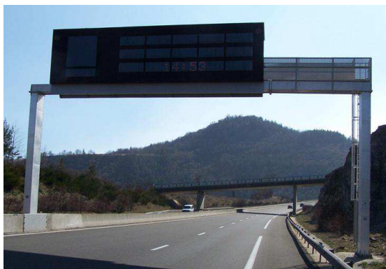
Photos 8 et 9 : Portique équipé de moyens d'accès permettant la maintenance du dispositif de signalisation par PMV
