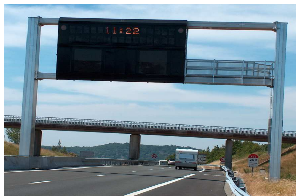
Photo 2 : Portique double traverse (porteur d'un caisson PMV)
